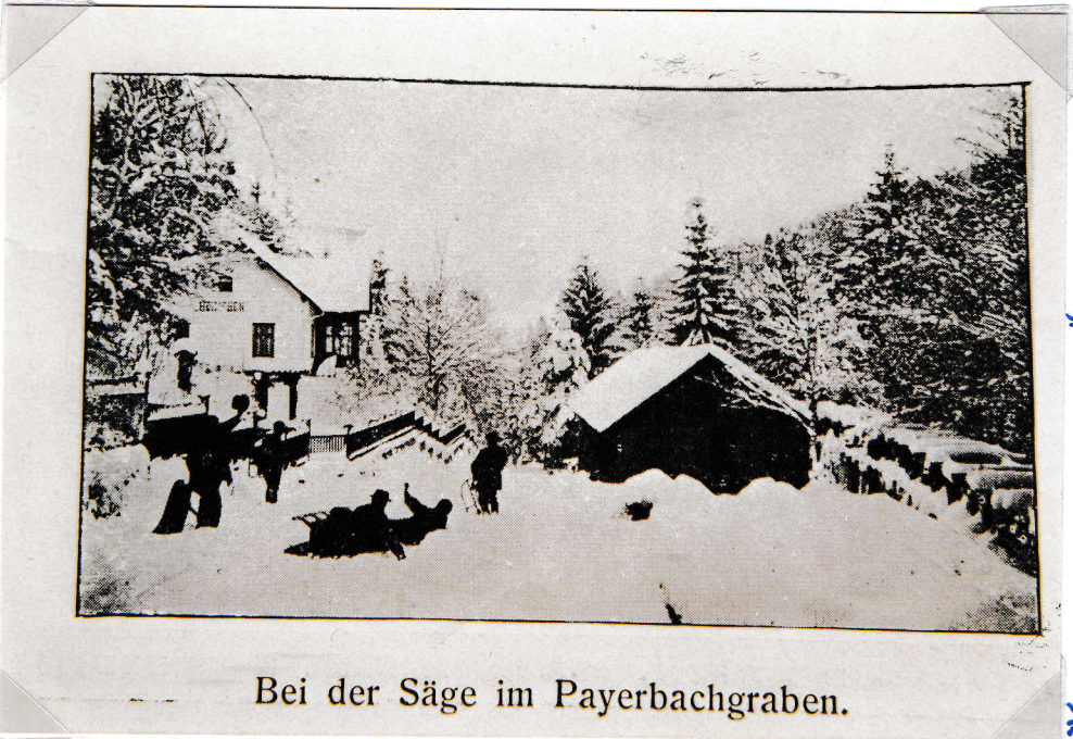
1905 Payerbach Graben Rodelbahn (bei d. Weinzettel Säge, Prasch), rechts: das Fluder (Fluter) Holz gezimmerte Wasser Zulaufrinne z. Wasserrad.
